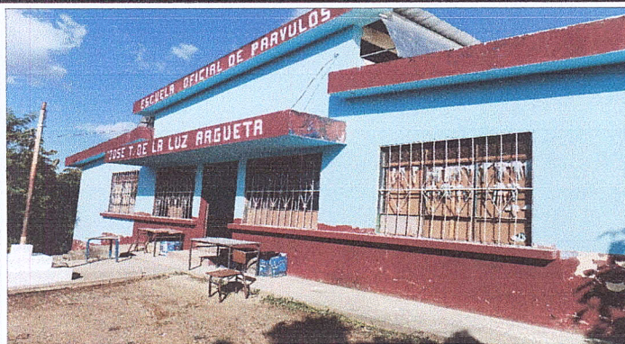
Pintura en muro exterior
