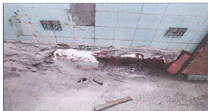
Mejoramiento de drenaje en los baños, sustitución de tubería de drenaje.
