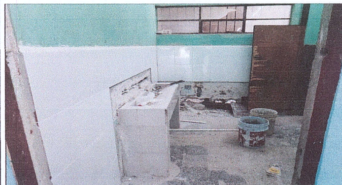
Instalación del nuevo azulejo en los baños
